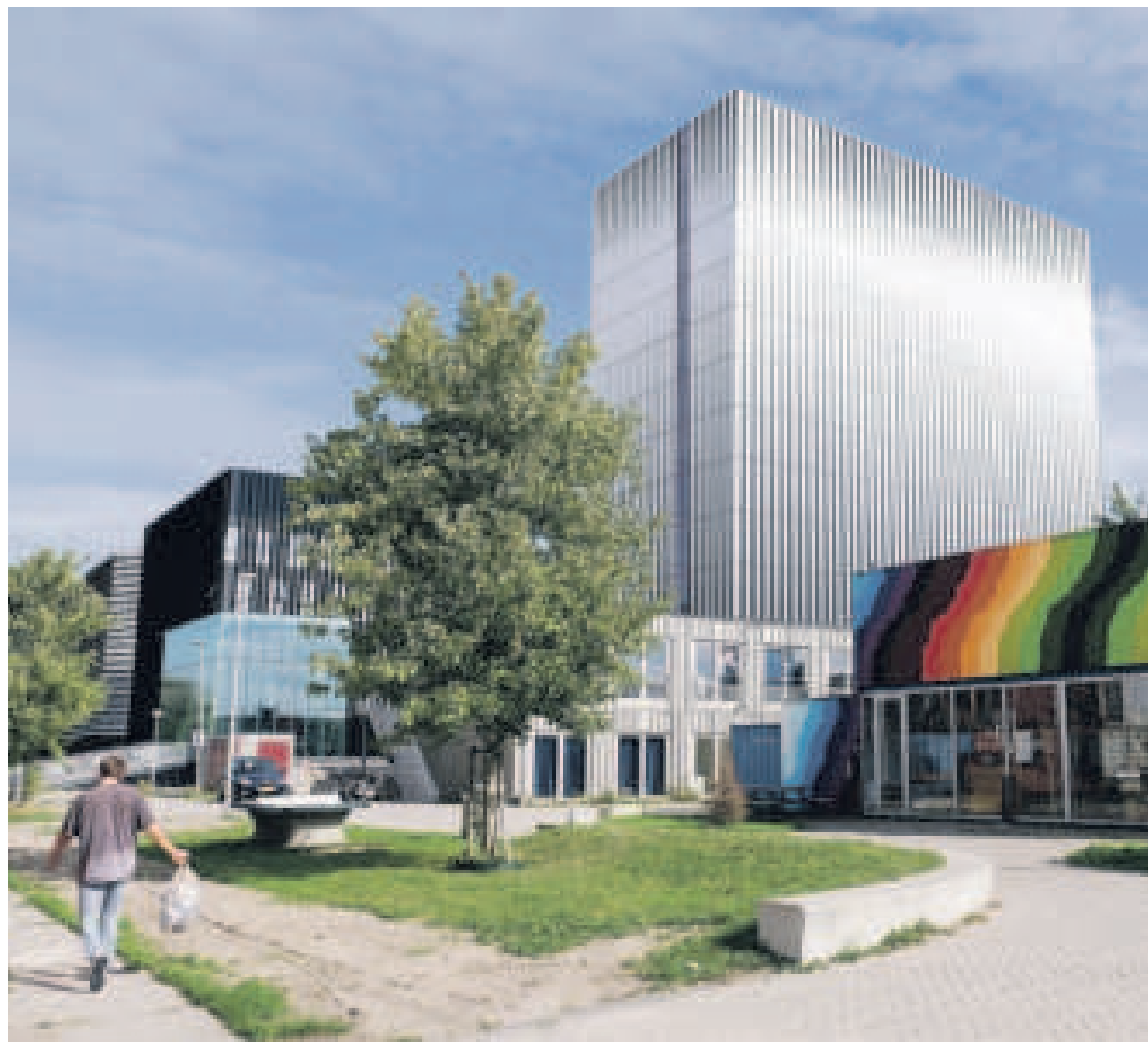
Datacenter Equinix AM4 op het Science Park in Amsterdam. FOTO KIM VAN DAM, ANP
